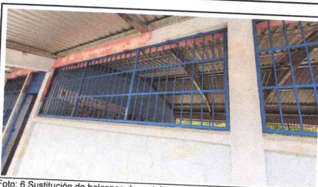
Foto 6 Sustitución de balcones de metal
