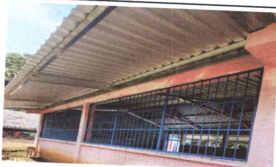
Foto 5: Sustitución de balcones de metal
