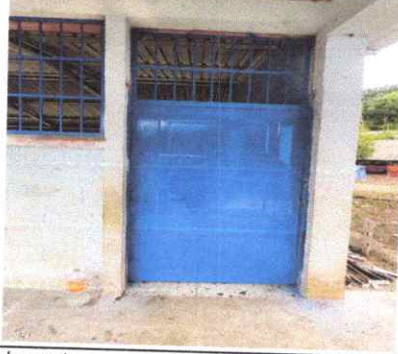
Foto 7: Sustrución de puerta
