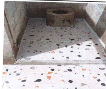
Foto 10: Sustrución de piso de cemento liquido por piso cerámico
