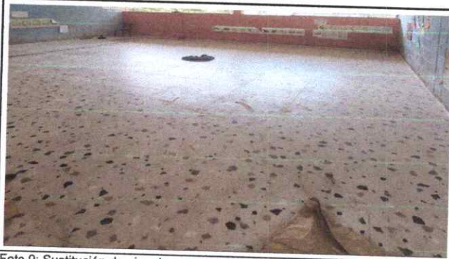
Foto 9: Sustrución de piso de cemento liquido por piso cerámico
