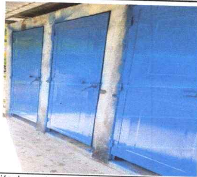
Foto 8: Sustrución de puerta en servicios sanitarios
