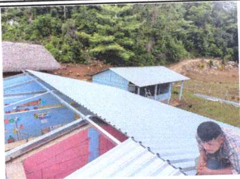
Foto 1: Sustrución de lámina, por lámina troquelada aluzinc calibre 26
