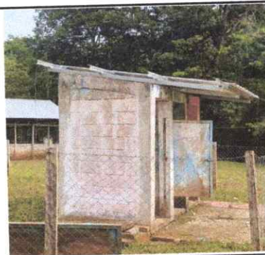
Foto 4: Sustrución de estructura de soporte de metal, por metal
