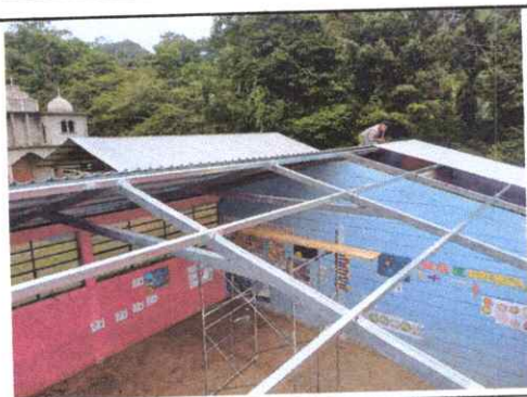
Foto 3: Sustrución de estructura de soporte de metal, por metal
