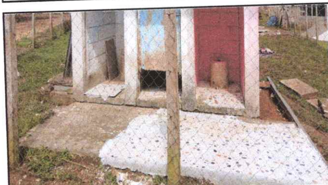
Foto 10: Sustrucción de piso de cemento liquido por piso cerámico
