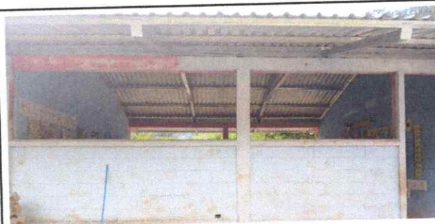
Foto 6: Sustrución de balcones de metal
