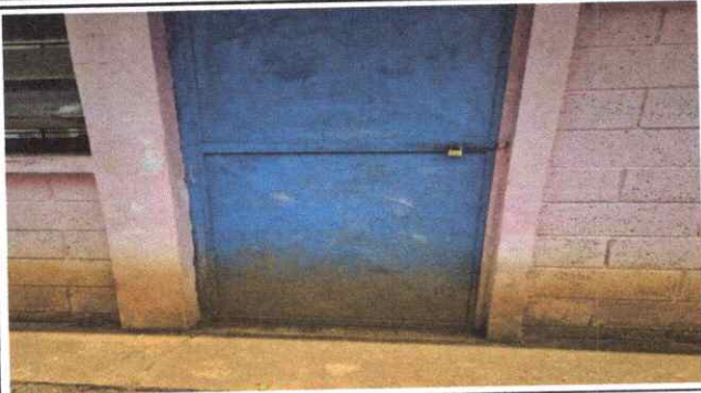
Foto 7: Sustrución de puerta
