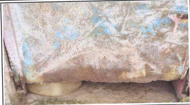
Foto 8: Sustrución de puerta en servicios sanitarios
