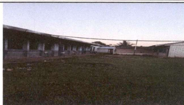
Foto 2: Pintura en muros exteriores e interiores.
