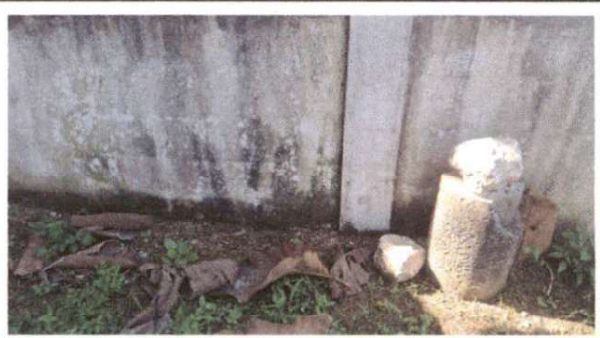
Foto 4: Repello en muro .
