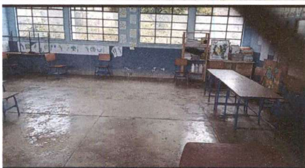
Foto1: Sustitución de piso de cemento líquido.
