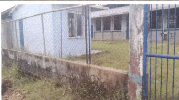
Foto 3: Reparación de Tubo HG y malla galvanizada.
