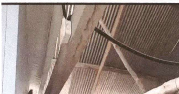
Foto 6: Reparación de cableado electrico.
