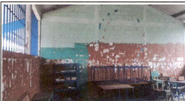
Foto 4: PINTURA EN MUROS INTERIORES Y EXTERIORES
