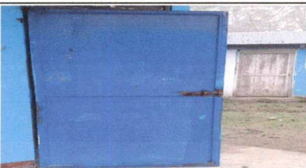
Foto 3: FABRICACIÓN E INSTALACIÓN DE PUERTA DE METAL EN MODULOS
