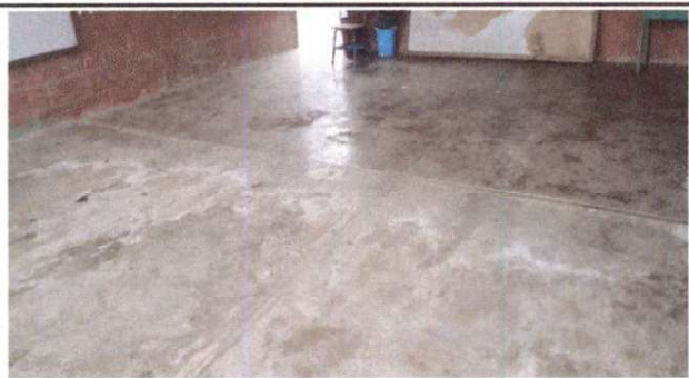
Foto 1: SUSTITUCIÓN DE PISO DE CEMENTO LÍQUIDO
