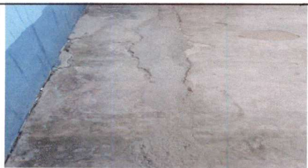
Foto 5: SUSTITUCIÓN DE PISO DE CEMENTO LÍQUIDO.
