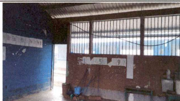
Foto 2: SUSTICIÓN DE DUCTO ELÉCTRICO MÁS ACCESORIOS
