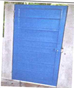
Foto 5: Sustitucion de puerta de madera por puerta de metal.
