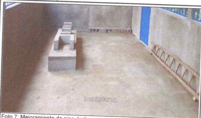
Foto 7: Mejoramiento de piso de tierra por piso de torta de concreto
