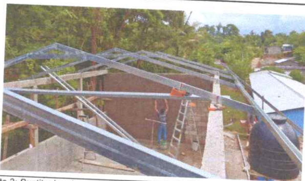
Foto 3: Sustitucion de elementos de fijacion
