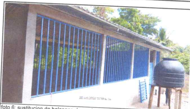
foto 6: sustitucion de balcones de madera por valcones de metal.
