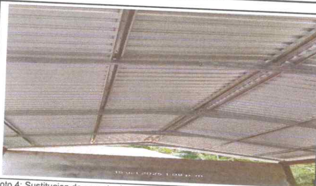
Foto 4: Sustitucion de soporte de madera, por metal.
