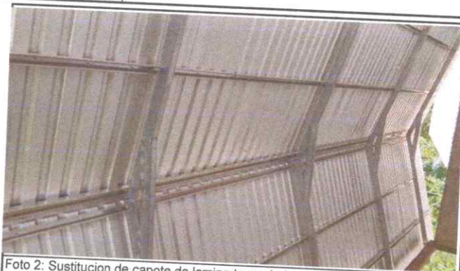
Foto 2: Sustitucion de capote de lamina troquelada
