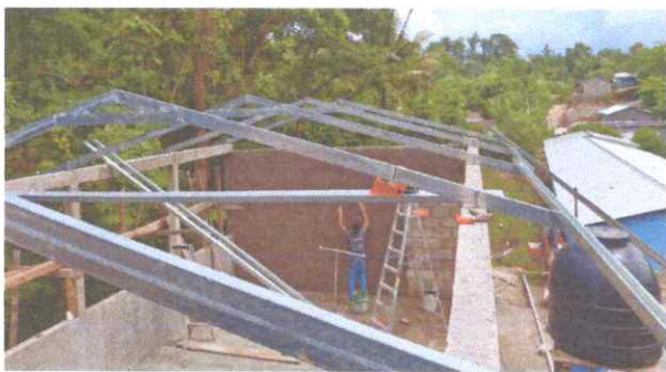
Foto 3: Sustitucion de elementos de fijacion
