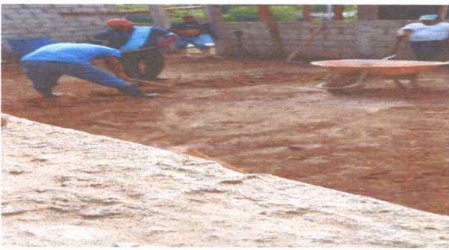
Foto 7: Mejoramiento de piso de tierra por piso de torta de concreto
