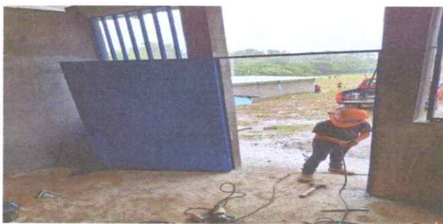
Foto 5: Sustitucion de puerta de madera por puerta de metal.
