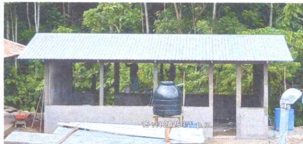
Foto 2: Sustitucion de capote de lamina troquelada
