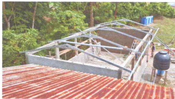
Foto 4: Sustitucion de soporte de madera, por metal.
