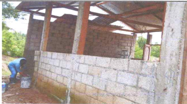
Foto 9: Repello en muro
