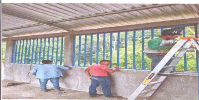
foto 6: sustitucion de balcones de madera por valcones de metal.
