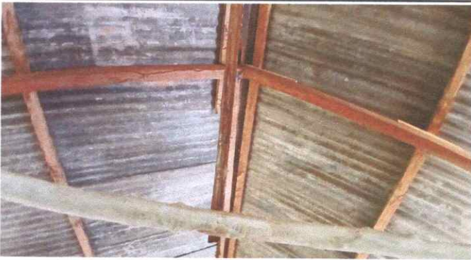
Foto 3: Sustrucion de elemento de fijacion
