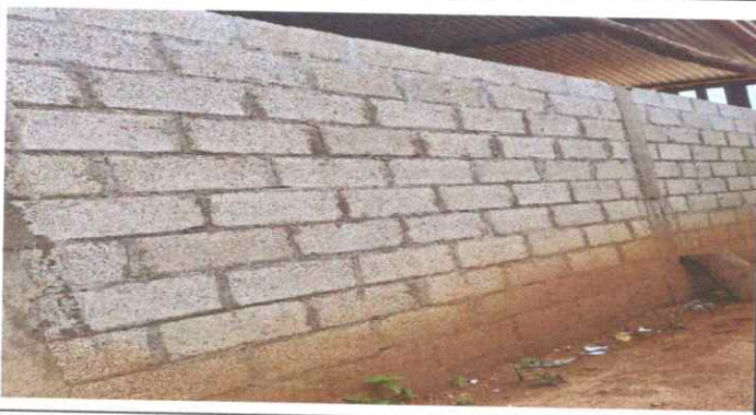
Foto 9: Repello en muro
