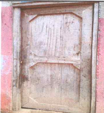
Foto 5: Sustrucion de Puerta de madera por puerta de metal
