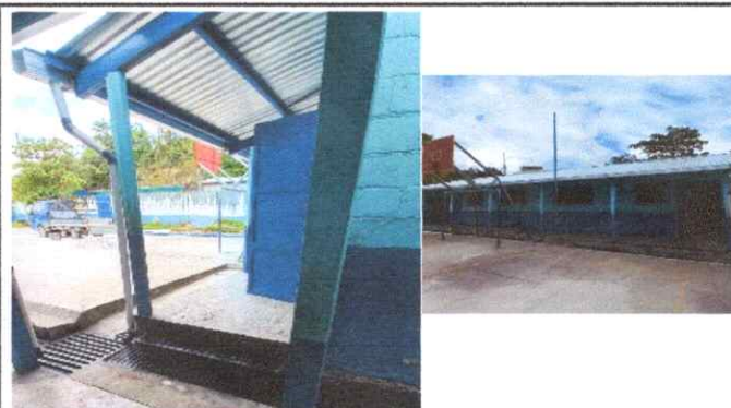
Foto 2: Sustrucción de canal de pvc
