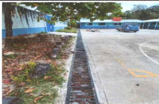
Foto 5: Reparación de cuneta de concreto (Cuneta + regilla)
