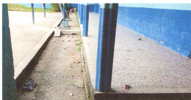
Foto 3: Reparación de cuneta de concreto (Cuneta + regilla)
