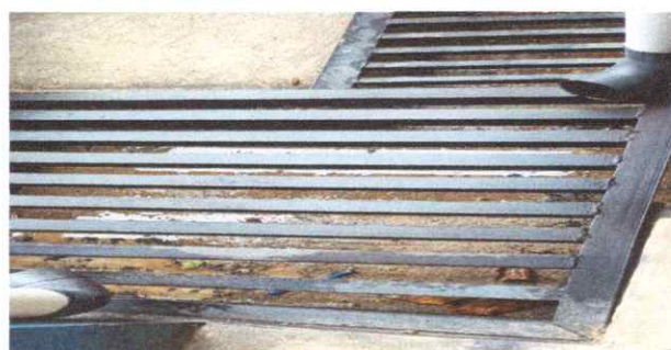
Foto 6: Caja de registro.
