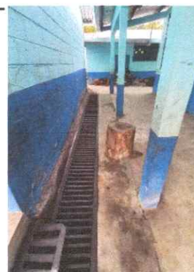
Foto 4: Reparación de cuneta de concreto (Cuneta + regilla)
