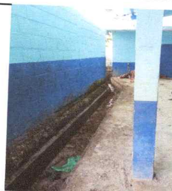
Foto 4: Reparación de cuneta de concreto (Cuneta + regilla)
