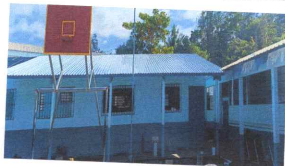
Foto 2: Sustitución de canal de pvc
