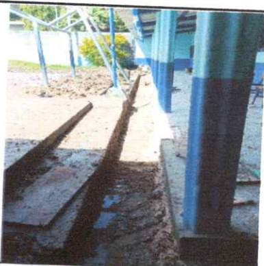
Foto 3: Reparación de cuneta de concreto (Cuneta + regilla)
