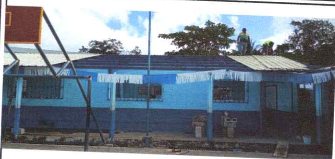
Foto 1: Sustitución de lámina, por lámina troquelada aluzinc calibre 26 y Capote
