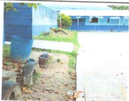
Foto 5: Reparación de cuneta de concreto (Cuneta + regilla)
