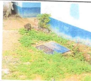
Foto 6: Mantenimiento a cajas de registro (1.00 x 1.00)
