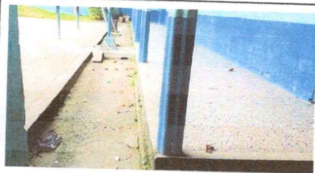
Foto 3: Reparación de cuneta de concreto (Cuneta + regilla)
