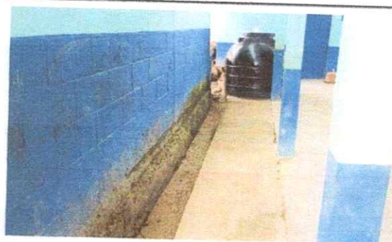
Foto 4: Reparación de cuneta de concreto (Cuneta + regilla)
