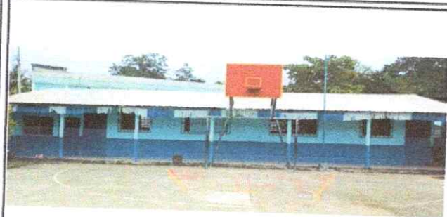
Foto 1: Sustrucción de lámina, por lámina troquelada aluzinc calibre 26 y Capote
