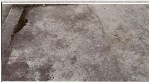
Foto 8: Reparación de banquetas de concreto
