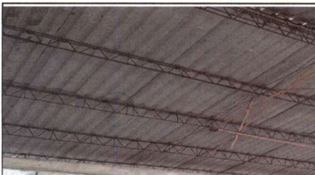
Foto 3: Sustitución de elementos de fijación
