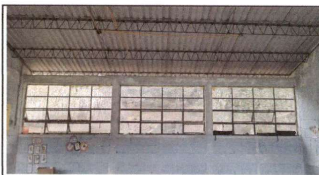
Foto 6: Sustitución de balcones de metal
