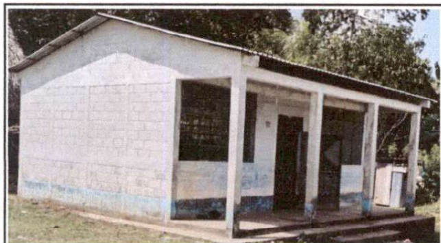
Foto 9: Pintura en muros exteriores e interiores
