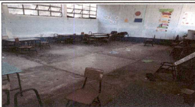
Foto 7: Sustitución de piso de cemento líquido
