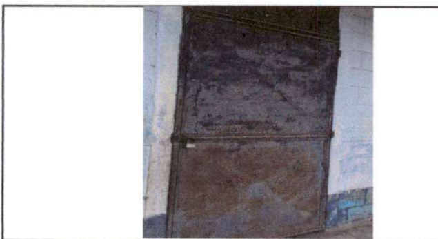
Foto 5: Sustitución de puerta
