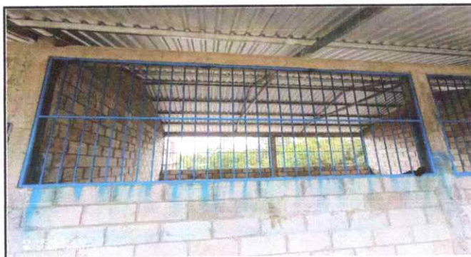
Foto 3: Suministro balcones de metal.
