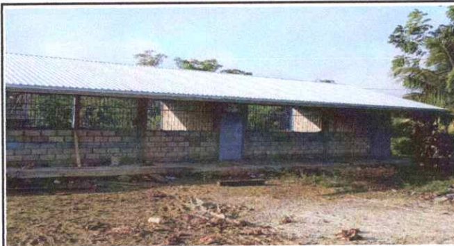
Foto 2: Sustitución de soporte de madera por metal.
