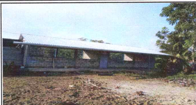
Foto1: Sustitución de lámina, por lámina troquelada.
