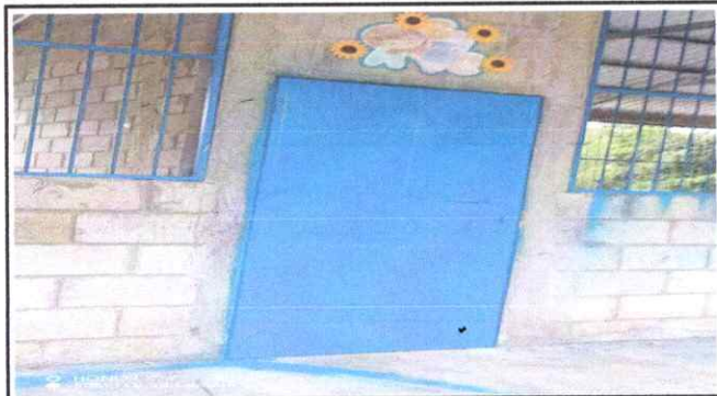
Foto 4: Suministro puertas de metal.
