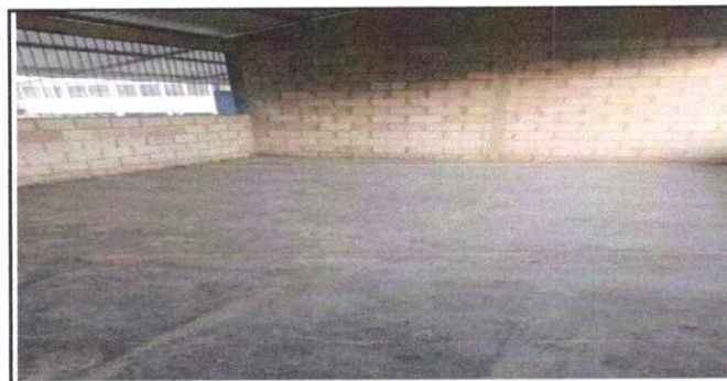
Foto 5: Mejoramiento de piso de tierra por piso de cemento líquido.
