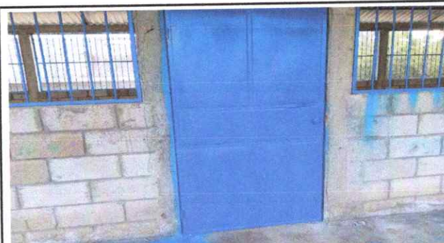
Foto 4: Suministro puertas de metal.
