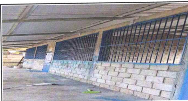
Foto 3: Suministro balcones de metal.
