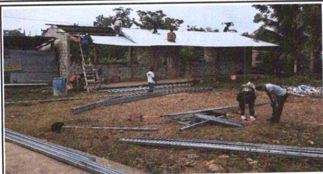
Foto 1: Sustitución de lámina, por lámina troquelada.
