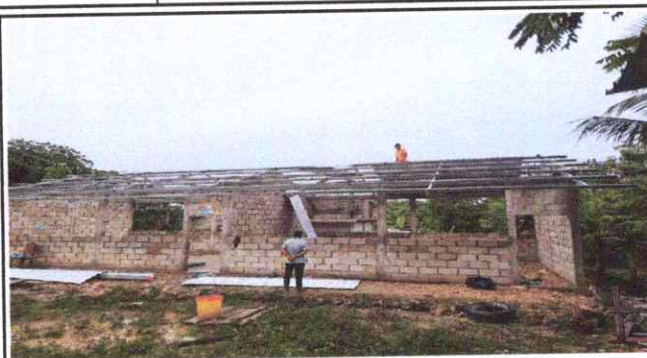
Foto 2: Sustitución de soporte de madera por metal.
