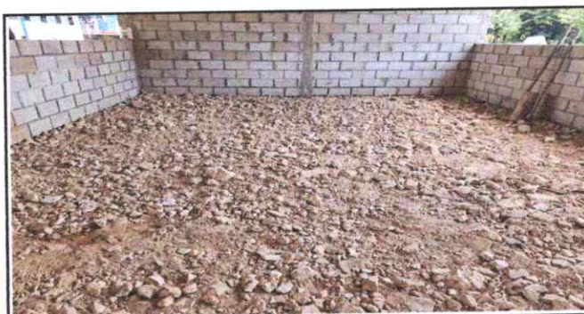
Foto 6: Mejoramiento de piso de tierra por piso de cemento líquido.
