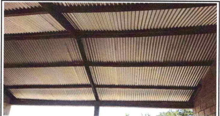
Foto 2: Sustrucción de Soporte de madera, por metal
