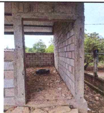
Foto 4: Suministro de Puertas de Metal
