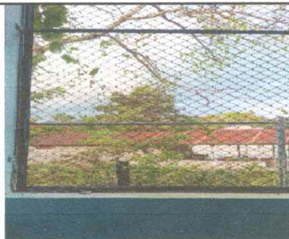
Foto 9: reparacion balcon de malla 1" x 1" x 1.00 cal. 16
