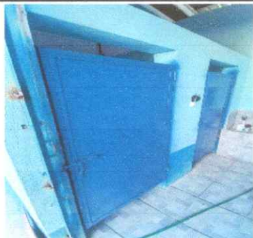
Foto 1: sustitución de puerta 0.70 m x 1.50 m
