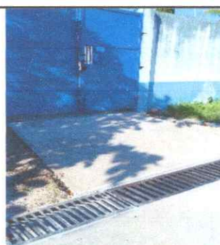
Foto 6: fundicon de piso (rampa de acceso)
