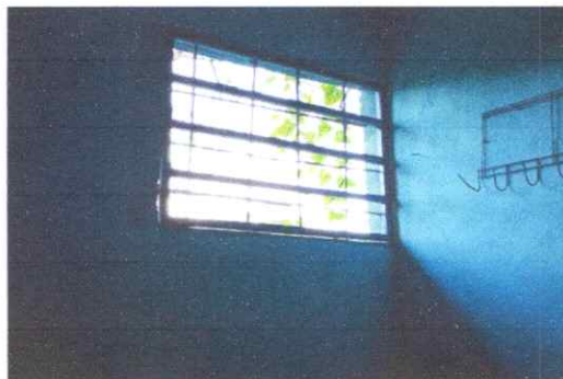
Foto 2: Sustitución de balcones de metal
