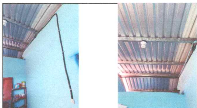
Foto 5: Reparación de lámparas
