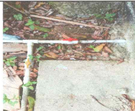
Foto 8: llave de paso para agua potable de 1/2" PVC
