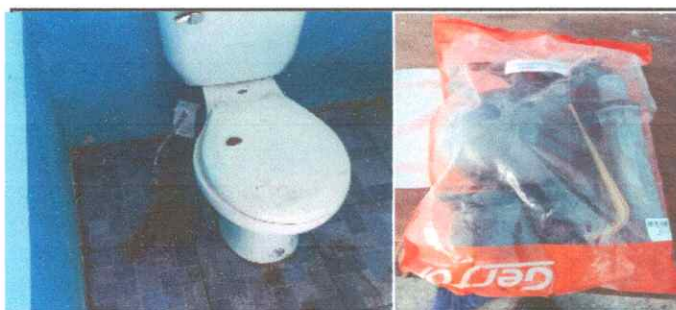
Foto 4: Sustitución de accesorios inodoro (contra llave, tubo de abasto)
