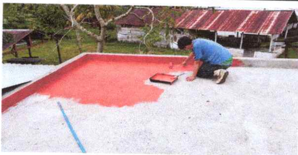
IMPERMEABILIZACION DE LOSA
