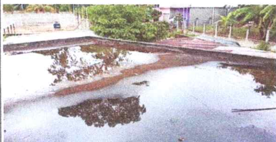
IMPERMEABILIZACIÓN DE LOSA
