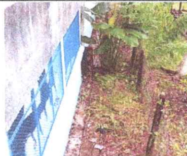
Reparación de tubo hg y malla galvanizada
