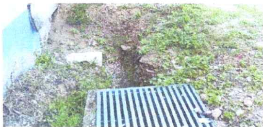
Mantenimiento a cajas de registro
