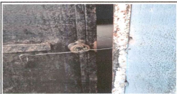
Foto 5: SUSTITUCION DE CHAPA
