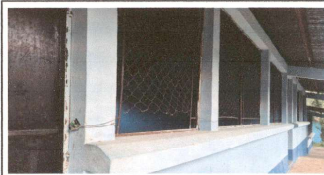
FOTO 4: SUSTITUCION DE DE BALCONES DE METAL
