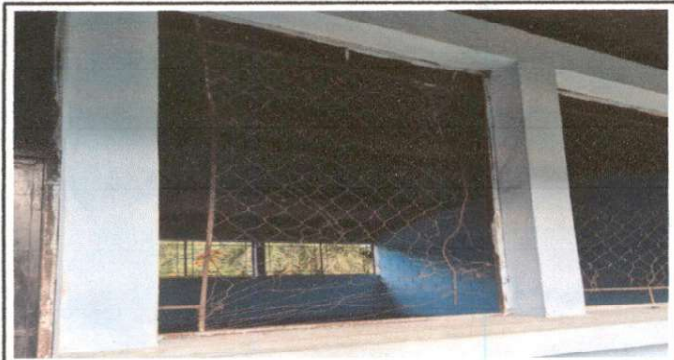
Foto 3: SUSTITUCION DE BALCONES DE METAL
