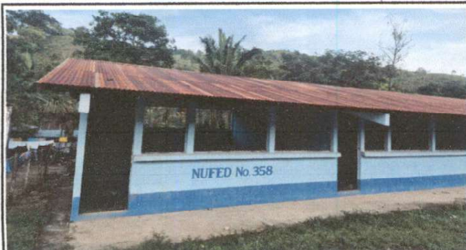
Foto1: SUSTITUCION DE LAMINA POR LAMINA TROQUELADA ALUZINC
