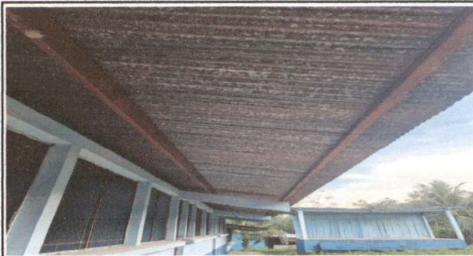
Foto 2: MANTENIMIENTO A ESTRUCTURA DE SOPORTE DE METAL
