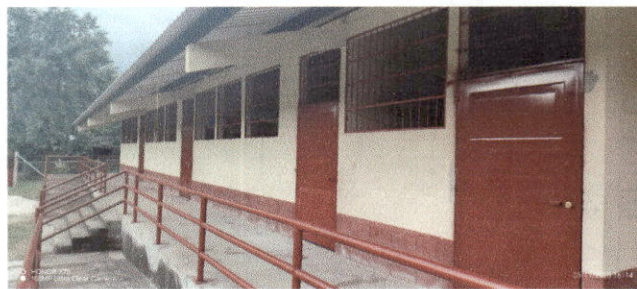
Foto 2: SUSTITUCION DE PUERTAS
