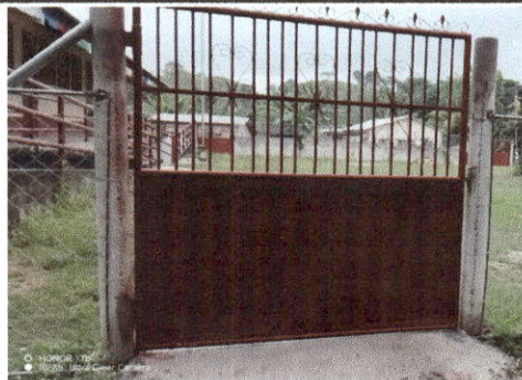
Foto 4: SUSTITUCION DE PORTON
