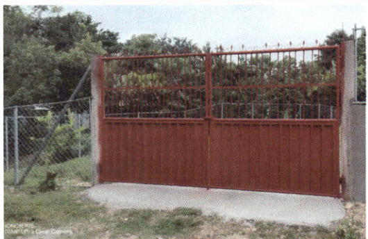
Foto 3: SUSTITUCION DE PORTON
