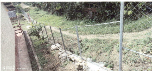
Foto 5: SUSTITUCION DE MURO PERIMETRAL
