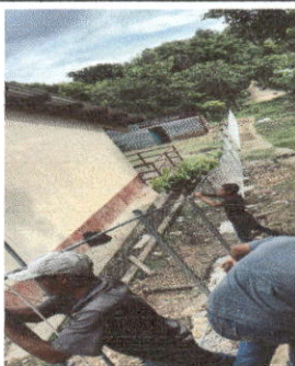
Foto 5: SUSTITUCION DE MURO PERIMETRAL
