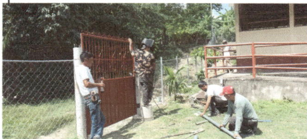
Foto 4: SUSTITUCION DE PORTON
