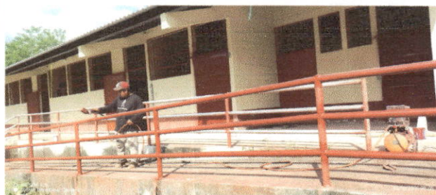
Foto 5: MANTENIMIENTO A BRARANDAS DE METAL
