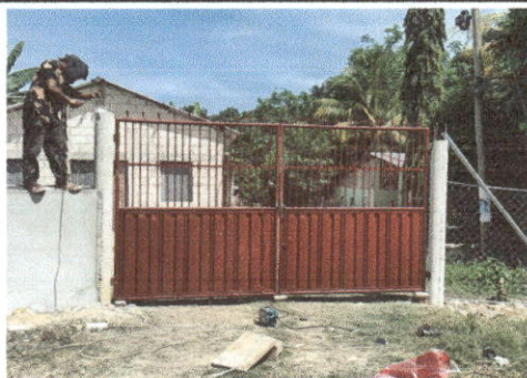
Foto 3: SUSTITUCION DE PORTON
