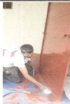
Foto 2: SUSTITUCION DE PUERTAS
