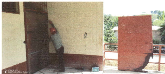
Foto 1: SUSTITUCION DE PUERTAS
