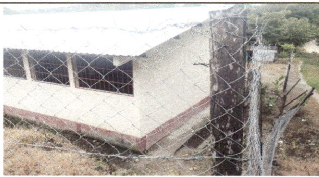
Foto 5: SUSTITUCION DE MURO PERIMETRAL
