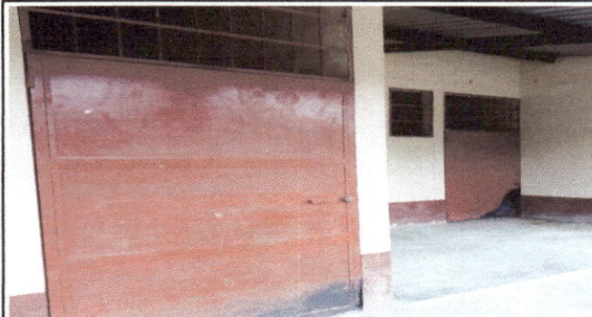
Foto 2: SUSTITUCION DE PUERTAS
