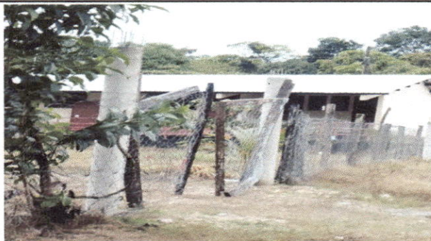
Foto 3: SUSTITUCION DE PORTON
