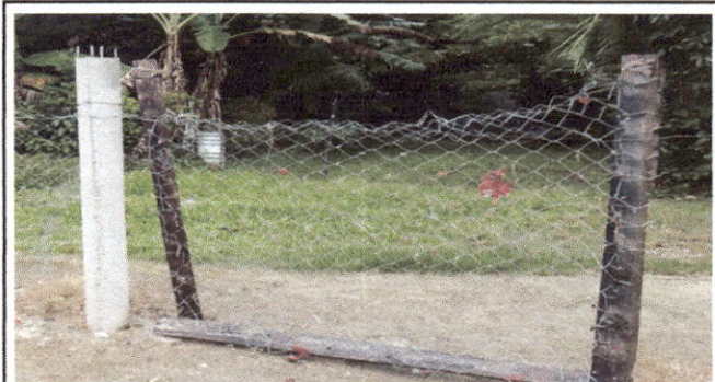
Foto 4: SUSTITUCION DE PORTON
