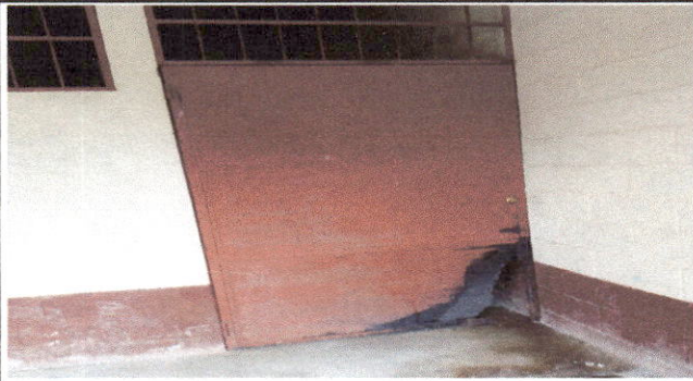
Foto 1: SUSTITUCION DE PUERTAS
