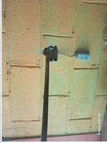
Foto: 3 REPARACION SISTEMA ELECTRICO
