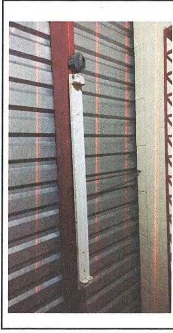
Foto 13: Sustitución de ducto eléctrico + accesorios
