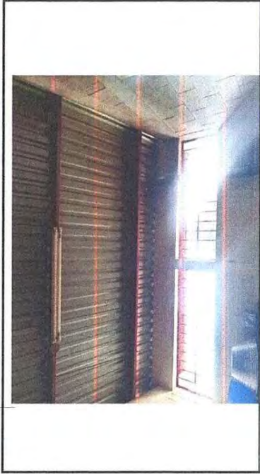
Foto 1: Sustitución de lámina, por lámina troquelada aluzinc calibre 26
