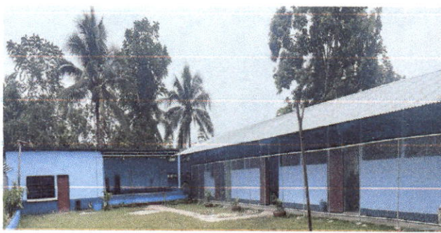
FOTO 6: Pintura en muros exteriores e interiores
