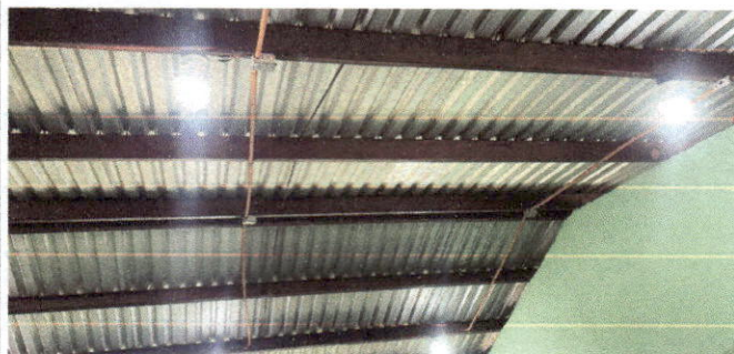
Foto 1 Sustitución de focos ahorradores Y Sutilución de plafoneras
