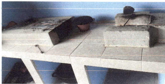
Foto: 2 Mantenimiento a estufa rural, Mejoramiento en fabricacion e instalacion de plancha de metal de 3 hornillas
