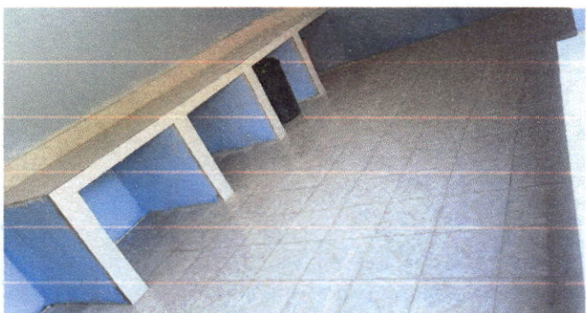
Foto 3: Mejoramiento, sustitución de piso liso por piso cerámico en cocina
