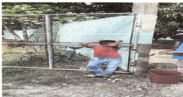
Foto: 4 Mantenimiento a portones de metal y Aplicación de repello de muros de contención
