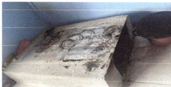
Foto: 2 Mantenimiento a estufa rural, Mejoramiento en fabricación e instalación de plancha de metal de 3 hornillas
