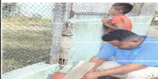
Foto: 5: Reparación de tubo hg y malla galvanizada
