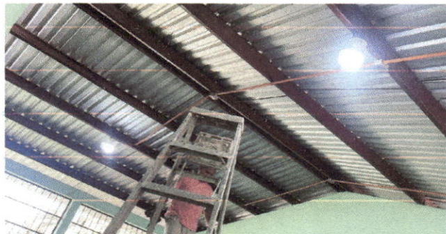
Foto 1 Sustitución de focos ahorradores Y Sustitución de plafoneras
