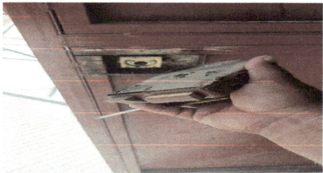
Foto 1: Sustitución de chapa
