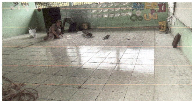
Foto 2: Mejoramiento, sustitución de piso liso por piso cerámico en aulas y dirección
