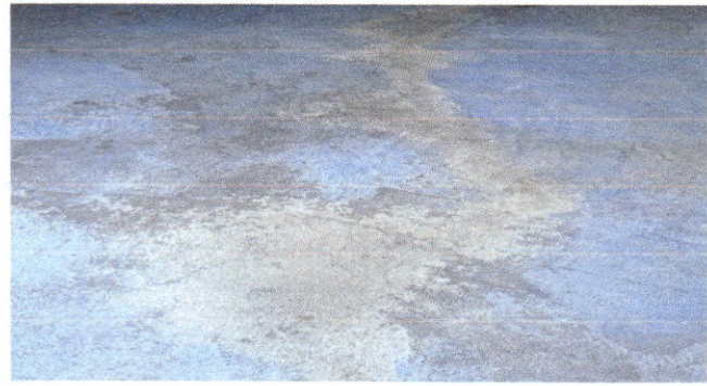
Foto 2: Mejoramiento, sustitución de piso liso por piso cerámico en aulas y dirección
