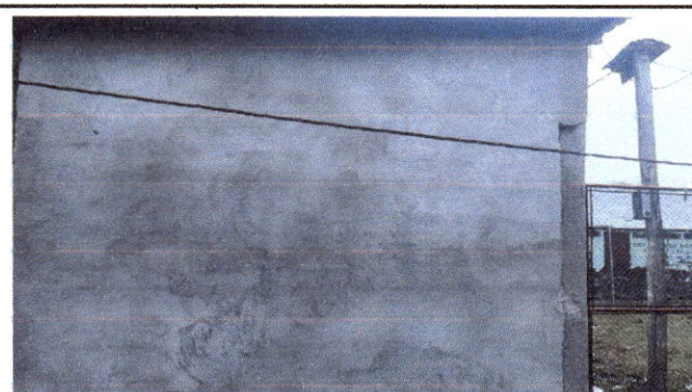
FOTO 6: Pintura en muros exteriores e interiores
