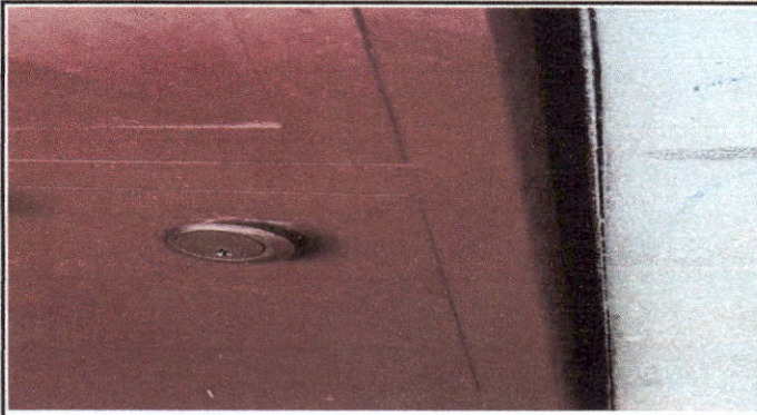
Foto 1: Sustitución de chapa
