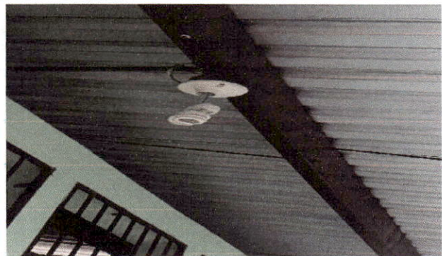
Foto 1 Sustrucción de focos ahorradores Y Sustrucción de plafoneras
