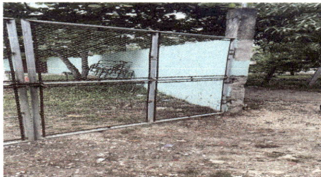
Foto: 4 Mantenimiento a portones de metal y Aplicación de repello de muros de contención
