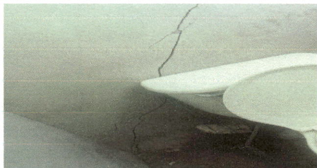
Foto 5: Sellado de grietas y fisuras en muros de baños
