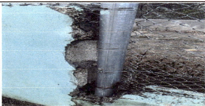
Foto: 5: Reparación de tubo de agua y malla galvanizada
