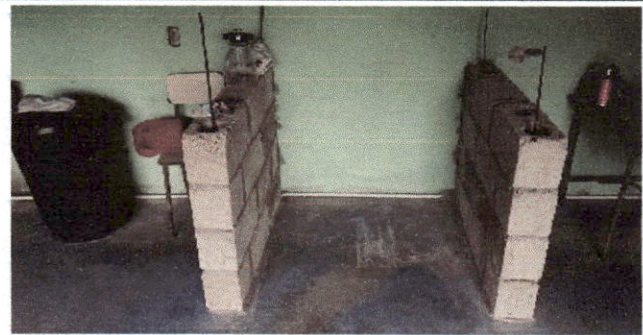
Foto 4: Repello en muro de cocina
