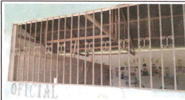
FOTO 4: SUSTITUCION DE BALCONES DE METAL
