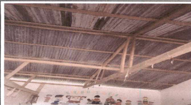
Foto 3: SUSTITUCION DE ESTRUCTURA DE MADERA POR ESTRUCTURA DE METAL
