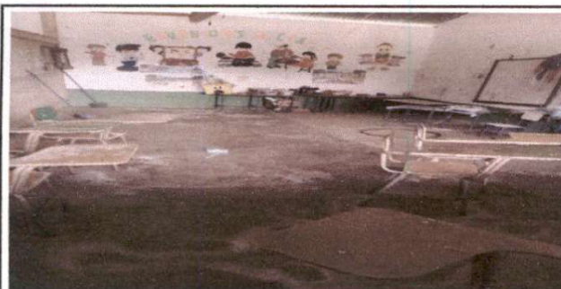
Foto 5: SUSTITUCION DE PISO DE CEMENTO LIQUIDO
