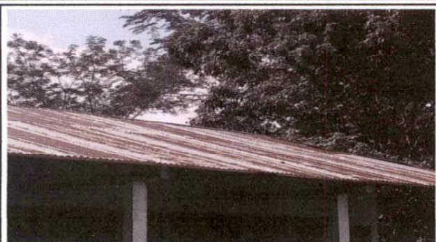
Foto1: SUSTITUCION DE LAMINA POR LAMINA TROQUELADA ALUZINC
