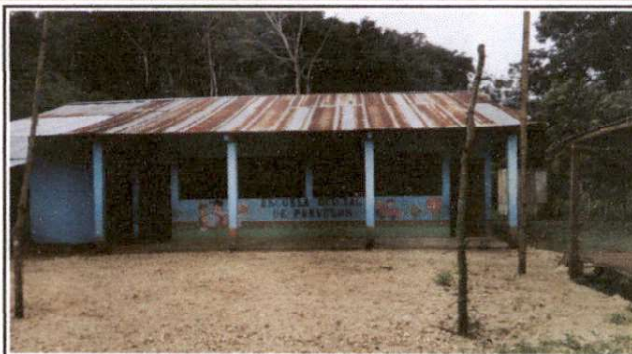
Foto 2: PINTURA EN MUROS EXTERIORES E INTERIORES
