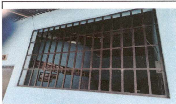
Foto 4: Mantenimiento a balcones de metal
