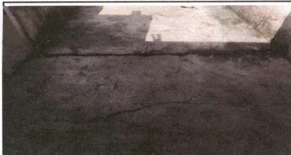
Foto 5: Sustrucción de piso de cemento liquido
