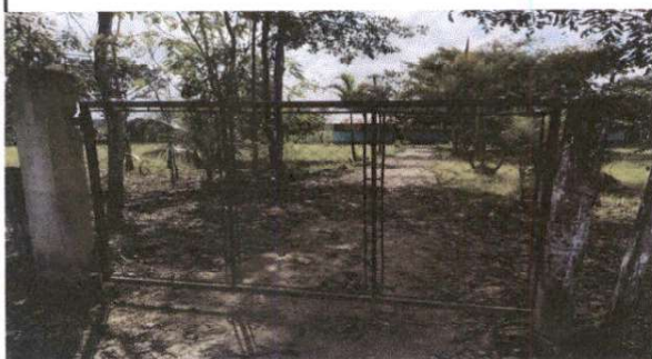
Foto1: Mantenimiento a porton de metal
