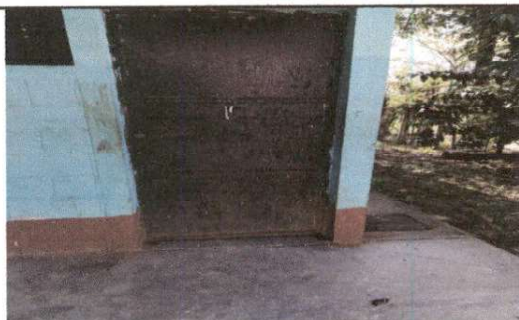
Foto 3: Mantenimiento a estructura
