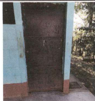
Foto 2: Sustitución de puerta en servicios sanitarios
