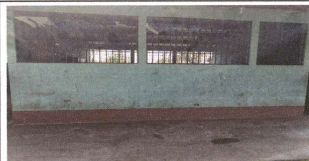
Foto 6: Pintura en muros exteriores e interiores
