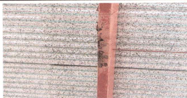
Foto 2: Mantenimiento a estructura de soporte de metal
