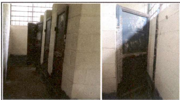
Foto 4: Pintura a puertas de servicios sanitarios
