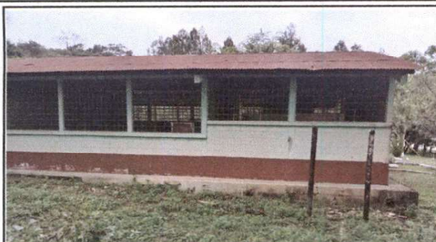
Foto1: Sustitución de lámina troquelada
