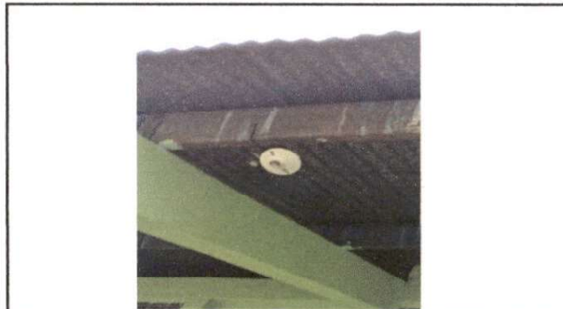
Foto 2: Sustitución de plafoneras
