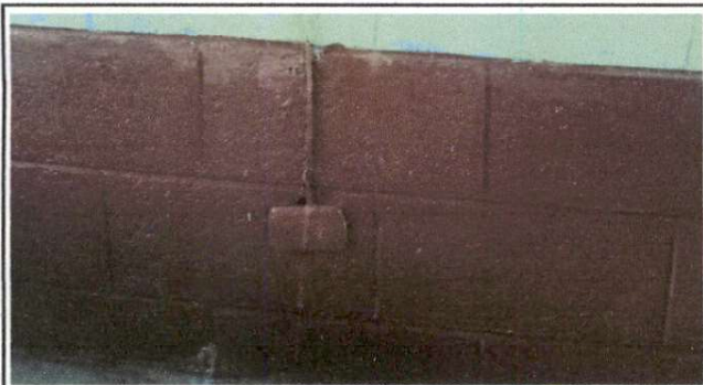
Foto 1: Sustitución de tomacorrientes
