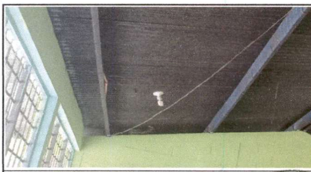
Foto 5: Sustitución de Cableado electrico
