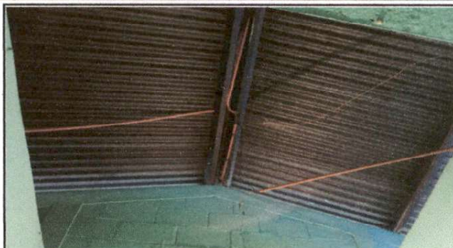
Foto 2: Sustrución de ducto electrico y sus accesorios
