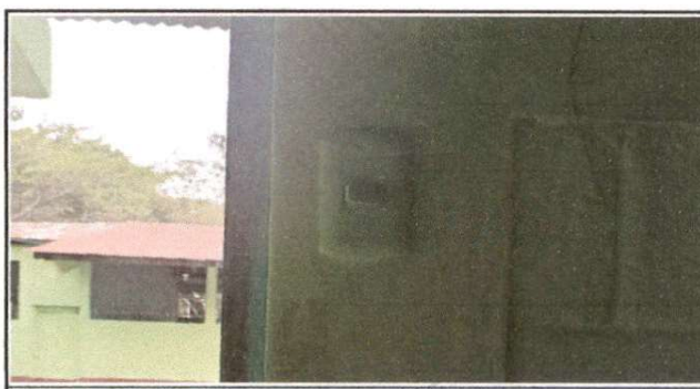
Foto 6: Sustitución de interruptores
