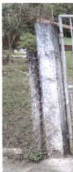
Foto1: Sustrución de columnas
