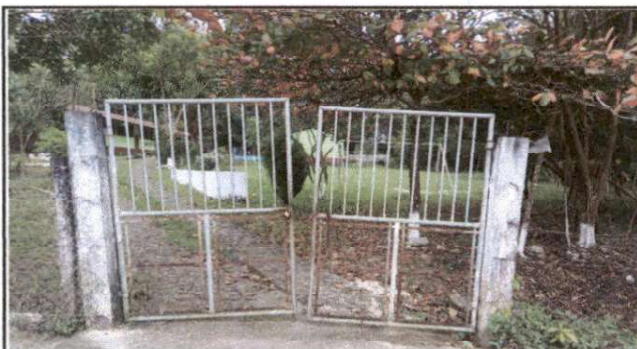
Foto 3: Mantenimiento de Porton de Metal
