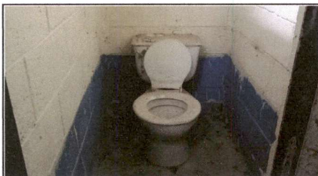
Foto 3: Sustitución de inodoros
