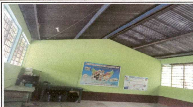
Foto 2: Mantenimiento a estructura de soporte de metal
