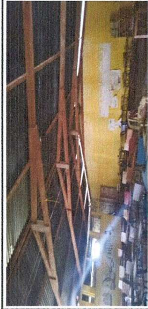
Foto 2: Sustitución de estructura de soporte de madera, por metal
