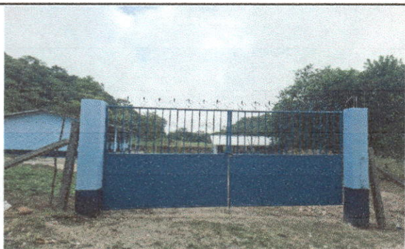
Foto 3: SUSTITUCION DE PORTON DE METAL
