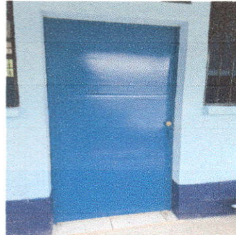
Foto 2: SUSTITUCION DE PUERTA
