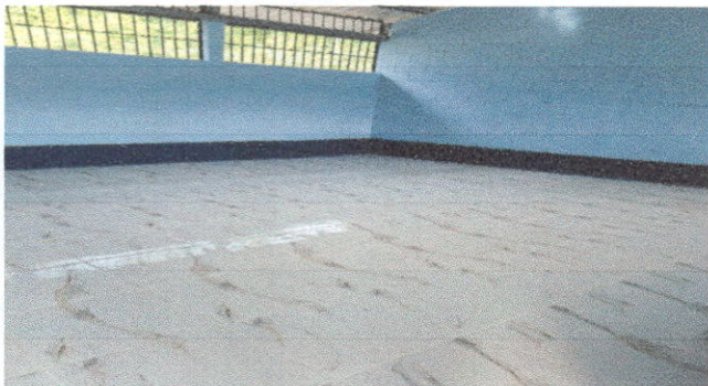
Foto 1: SUSTITUCION DE PISO LIQUIDO POR CERAMICO
