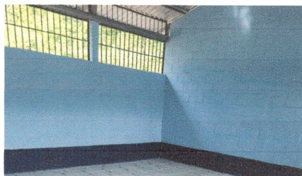
Foto 4: PINTURA EN MURO INTERIOR Y EXTERIOR
