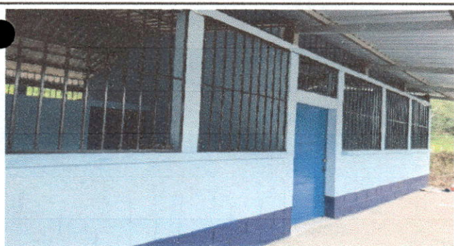
Foto 5: MANTENIMIENTO A BALCONES
