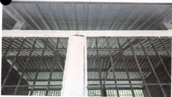
Foto 5: MANTENIMIENTO A BALCONES
