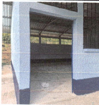
Foto 2: SUSTITUCION DE PUERTA
