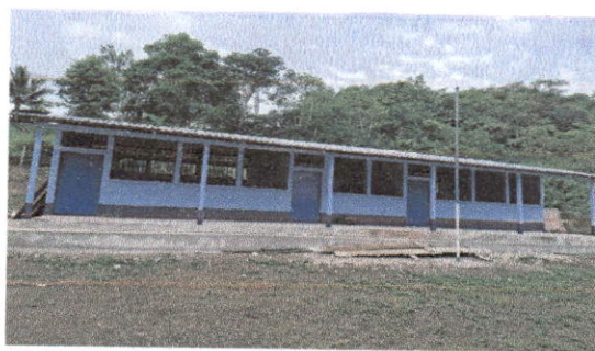
Foto 6: PINTURA EN MUROS INTERIORES Y EXTERIOR
