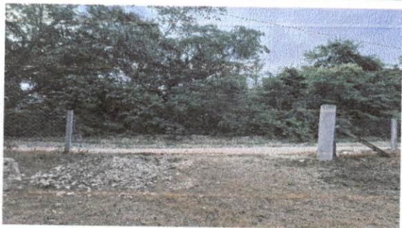
Foto 3: SUSTITUCION DE PORTON DE METAL
