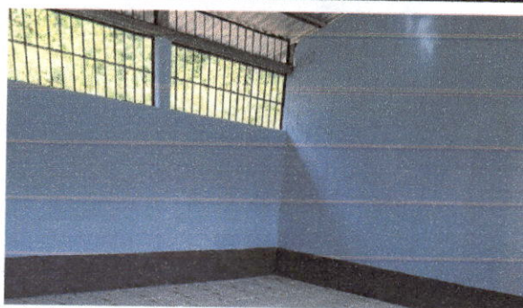
Foto 4: PINTURA EN MURO INTERIOR Y EXTERIOR
