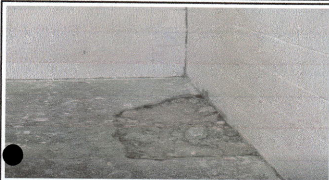
Foto 1: SUSTITUCION DE PISO LIQUIDO POR CERAMICO
