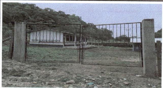
Foto 3: SUSTITUCION DE PORTON DE METAL
