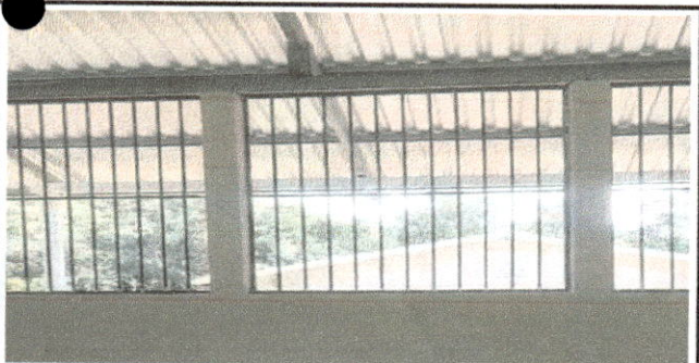
Foto 5: MANTENIMIENTO A BALCONES
