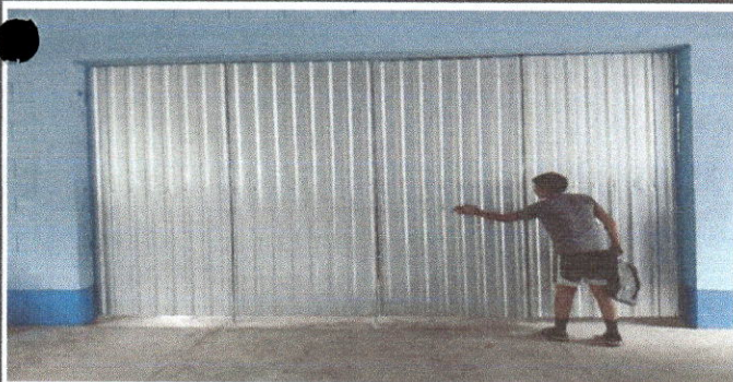
Foto 5: División entre aulas
