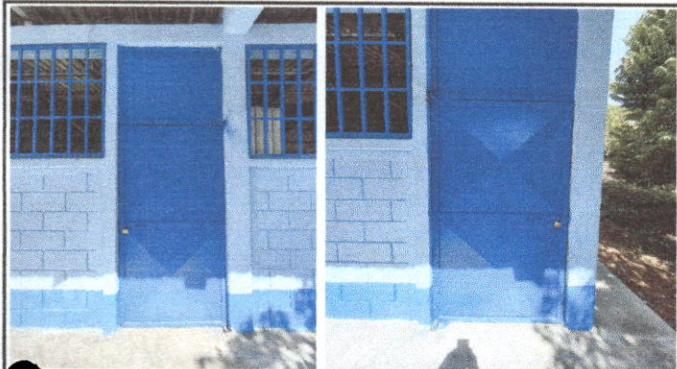
Foto 7: Mantenimiento a estructura puerta (lijado, cepillado, aplicación de pintura), en establecimiento
