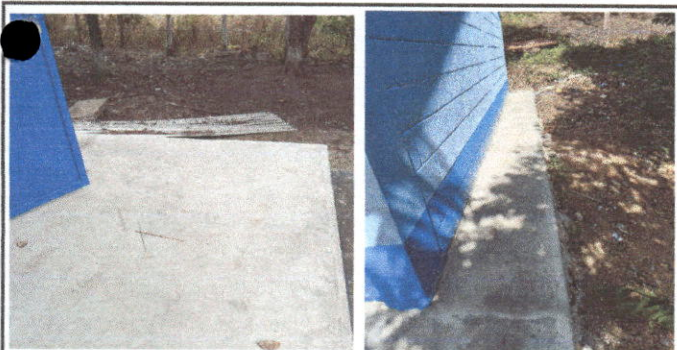
Foto 10. Reparación de banquetas de concreto
