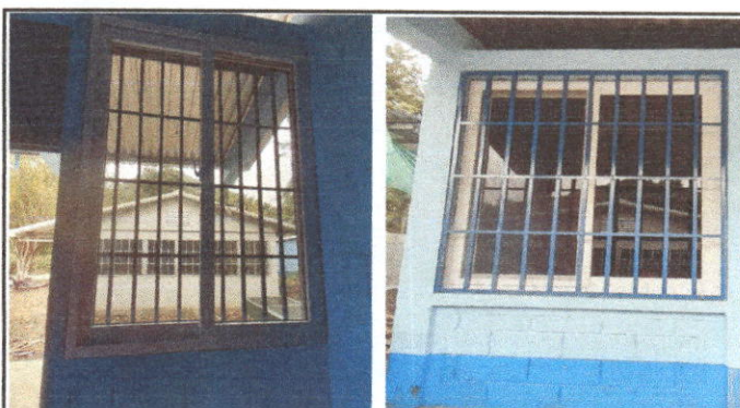
Foto 10: abricacion e intalación de ventana de vidrio de pvc
