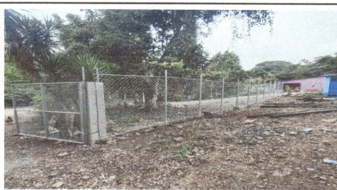
Foto 4: Mejoramiento y reparación de tubo hg y malla galvanizada
