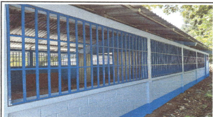
Foto 9: Sustitución de balcones de metal
