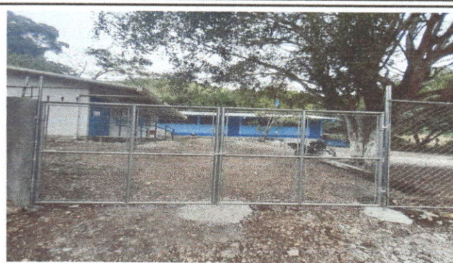
Foto 8: Fabricacion e instalacion de porton de metal
