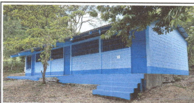
Foto 11. Pintura en muros exteriores e interiores
