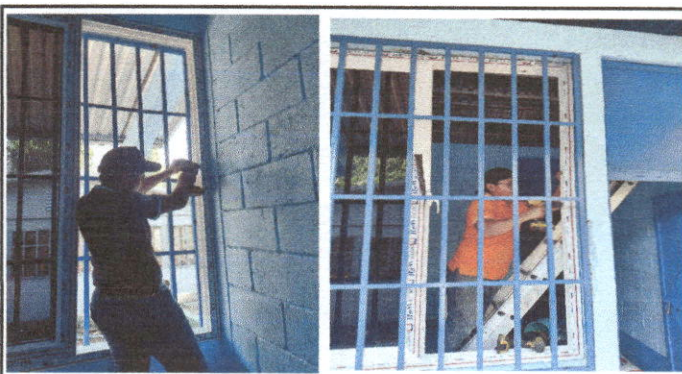
Foto 4: fabricacion e intalación de ventana de vidrio de pvc
