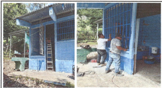
Foto 3: Sustitución de balcones de metal
