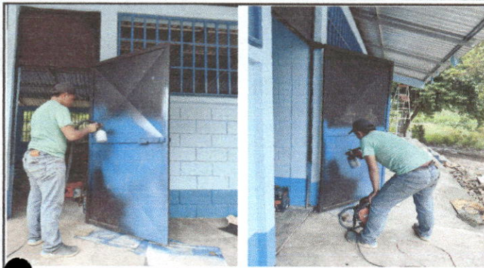
Foto 1: Mantenimiento a estructura puerta (lijado, cepillado, aplicación de pintura), en establecimiento
