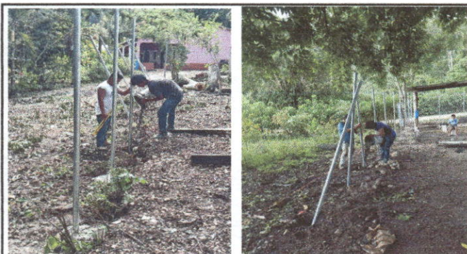
Foto 3 Mejoramiento y reparación de tubo hg y malla galvanizada
