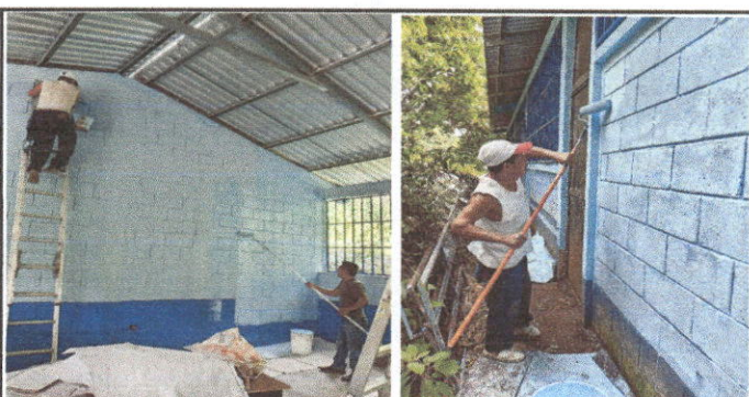
Foto 6: Pintura en muros exteriores e interiores
