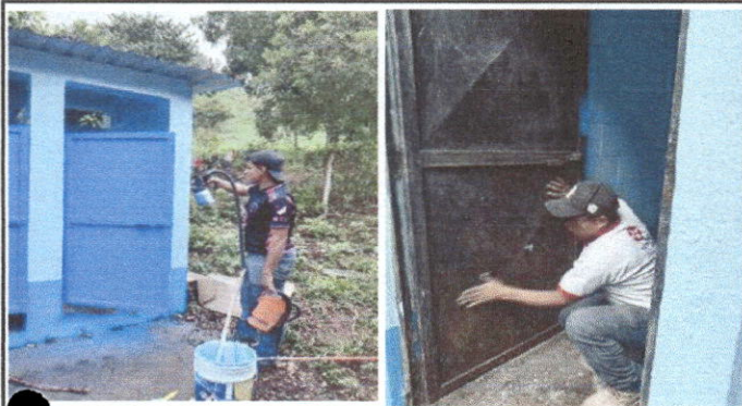
Foto 1: Mantenimiento a estructura puerta (lijado, cepillado, aplicación de pintura) en baños
