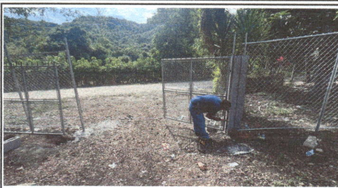
Foto 2: Fabricacion e instalacion de porton de metal
