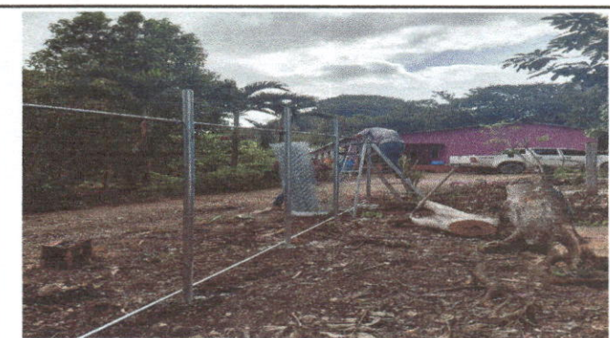
Foto 4: Mejoramiento y reparación de tubo hg y malla galvanizada
