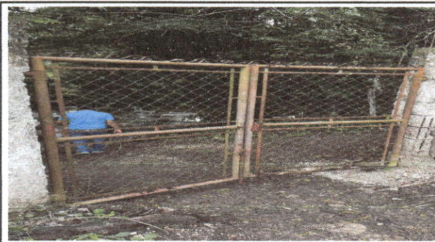
Foto 2: Fabricacion e instalacion de porton de metal
