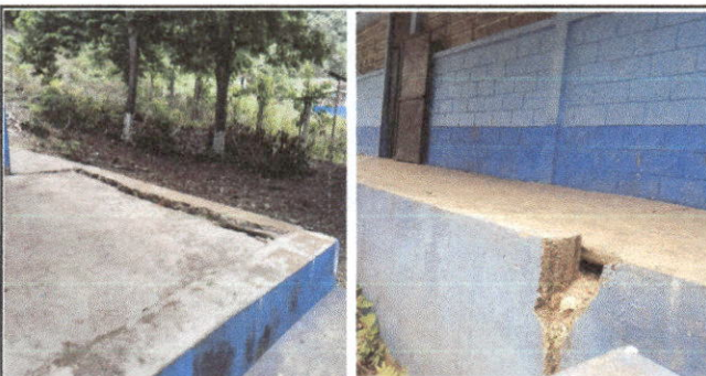
Foto 5: Reparación de banquetas de concreto
