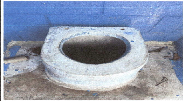
Foto 8: Sustitución de tapadera de inodoros
