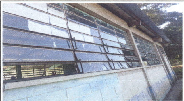
Foto 3 Sustitución de balcones de metal
