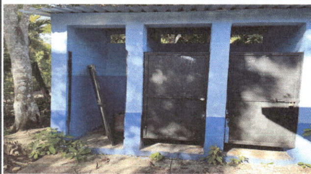
Foto 7: Mantenimiento a estructura puerta (lijado, cepillado, aplicación de pintura) en los baños
