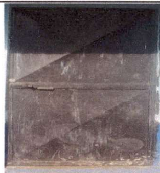
FOTO 4: SUSTITUCION DE CHAPA
