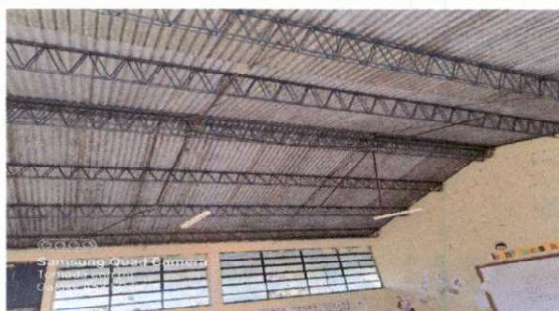
Foto 5: REPARACION DE CABLEADO ELECTRICO
