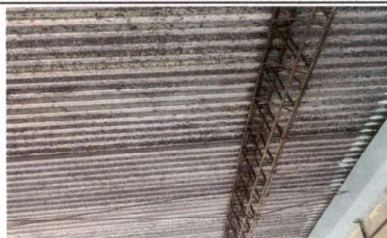
Foto 2: SUSTITUCION DE ESTRUCTURA PORTANTE DE METAL
