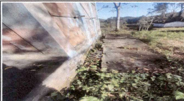
Foto 3: REPARACION DE BANQUETAS DE CONCRETO
