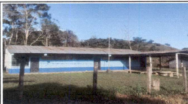
Foto1: SUSTITUCION DE LAMINA POR LAMINA TROQUELADA ALUZINC
