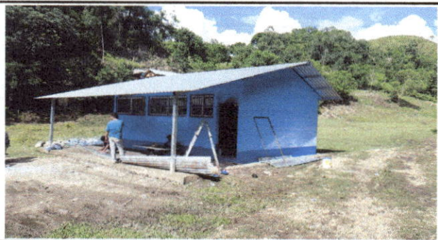
Foto 5: Pintura en muros exteriores e interiores
