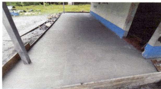
Foto 4: Sustitución de piso de torta de concreto
