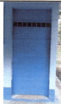
Foto 2: Sustitución de puerta de metal
