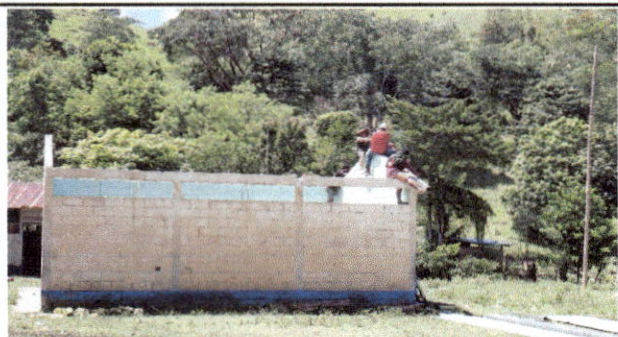
Foto 1: Sustrucción de lámina por lámina troquelada aluzinc calibre 26 u sustrucción de estructura de soporte de madera, por metal
