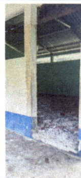
Foto 2: Sustrucción de puerta de metal
