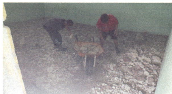
Foto 6: Sustrucción de piso de cemento líquido
