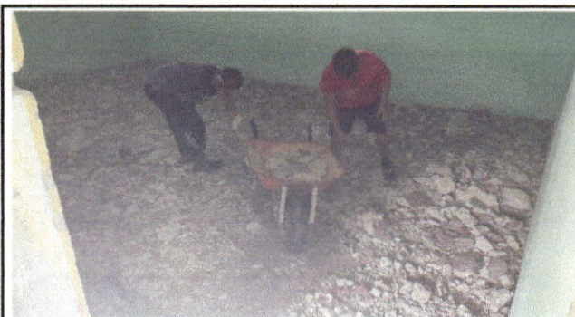
Foto 4: Sustrucción de piso de torta de concreto
