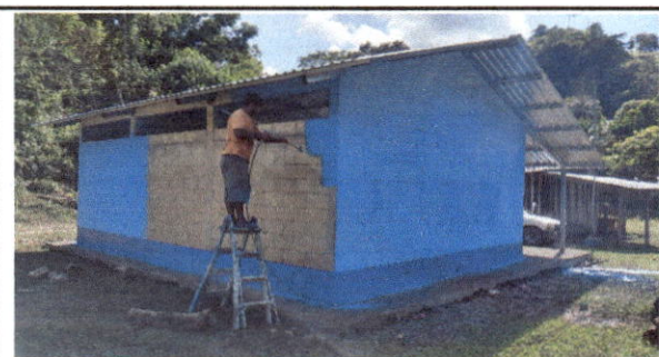
Foto 5: Pintura en muros exteriores e interiores
