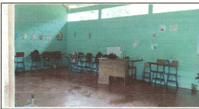
Foto: 6 Sustitución de piso de cemento liquido
