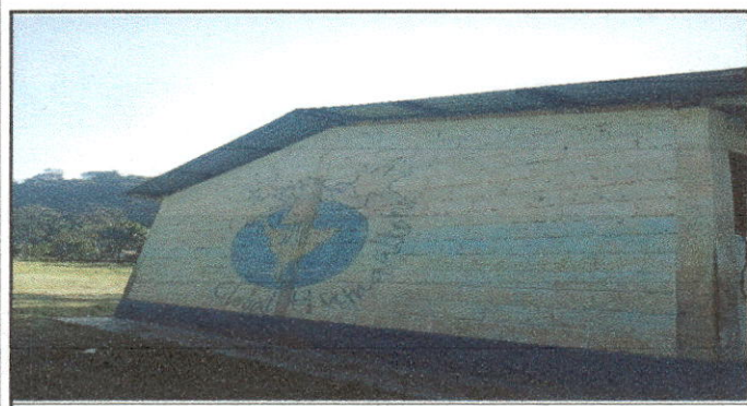
Foto: 5 pintura en muros exteriores e interiores
