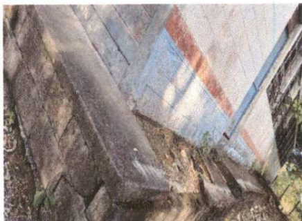
Foto 5: REPARACION DE BANQUETAS DE CONCRETO
