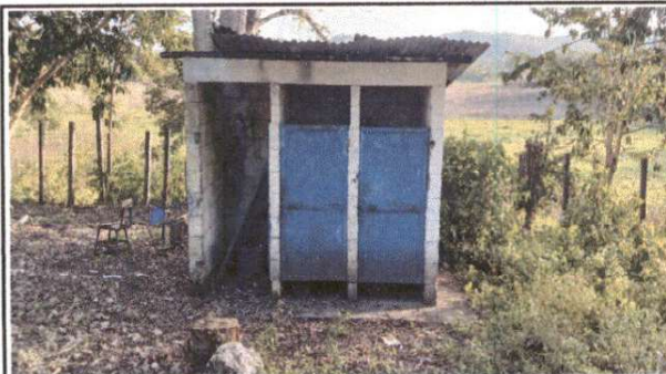
Foto 3: SUSTITUCION DE PUERTAS EN SERVICIOS SANITARIOS
