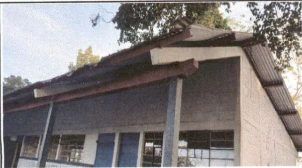
Foto 1: SUSTITUCION DE LAMINA POR LAMINA TROQUELADA ALUZINC
