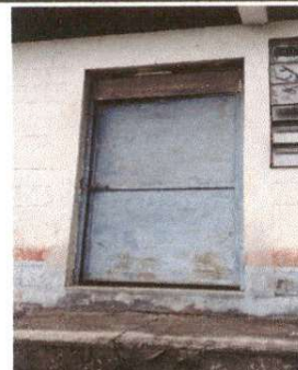
FOTO 4: SUSTITUCION DE PUERTAS
