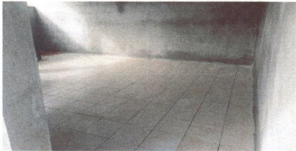
Foto 3: SUSTITUCION DE PISO LIQUIDO
