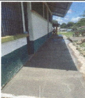
Foto 5: SUSTITUCION DE BANQUETA
