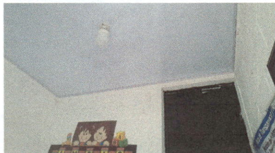
Foto 1: MEJORAMIENTO DE TECHO DE LAMINA CON RECUBRIMIENTO DE PVC.
