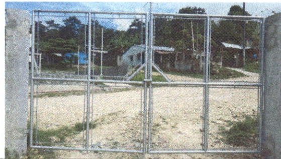
Foto 4: SUSTITUCION DE PORTON DE ENTRADA PRINCIPAL
