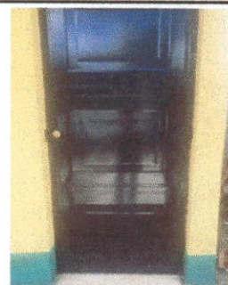
Foto 6: SUSTITUCION DE PUERTA DE METAL
