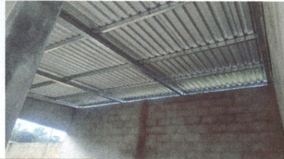
Foto 2: SUSTITUCION DE ESTRUCTURA
