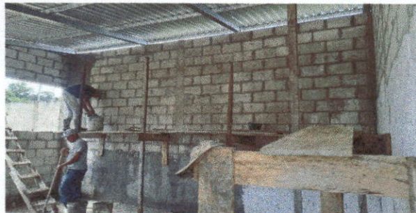
Foto 2: REPELLO EN MURO
