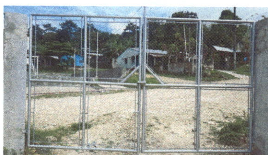
Foto 4: SUSTITUCION DE PORTON DE ENTRADA PRINCIPAL
