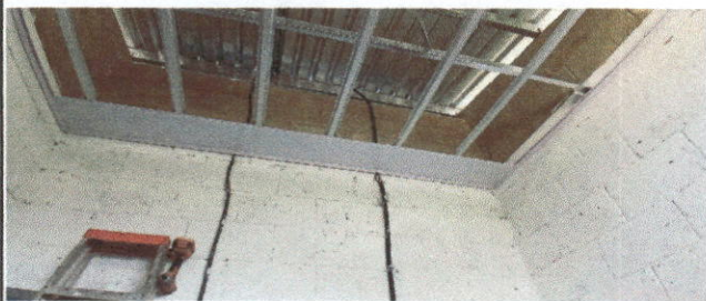
Foto 1: MEJORAMIENTO DE TECHO DE LAMINA CON RECUBRIMIENTO DE PVC.
