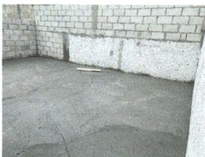
Foto 3: SUSTITUCION DE PISO LIQUIDO
