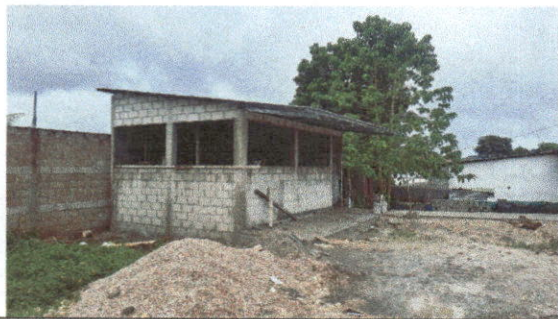
Foto 1: SUSTITUCION DE TECHO
