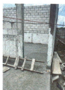
Foto 6: SUSTITUCION DE PUERTA DE METAL
