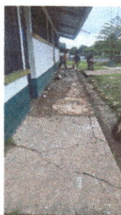
Foto 5: SUSTITUCION DE BANQUETA
