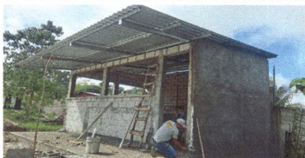
Foto 3: REPELLO EN MURO
