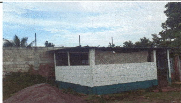
Foto 1: SUSTITUCION DE TECHO
