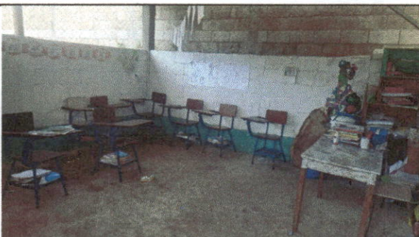
Foto 3: SUSTITUCION DE PISO LIQUIDO
