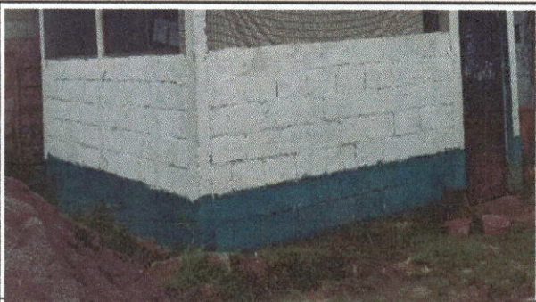
Foto 3: REPELLO EN MURO
