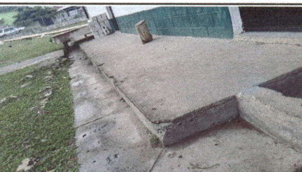
Foto 5: SUSTITUCION DE BANQUETA
