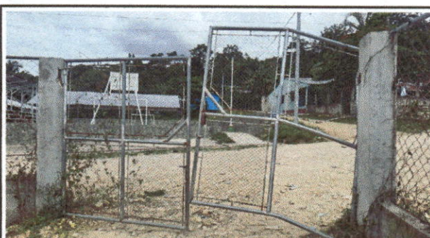
Foto 4: SUSTITUCION DE PÓRTON DE ENTRADA PRINCIPAL
