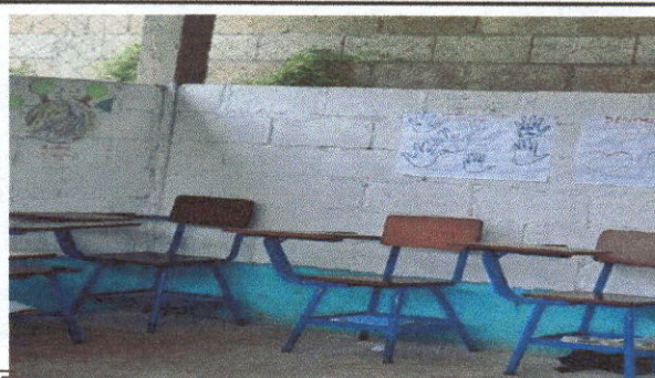
Foto 2: REPELLO EN MURO
