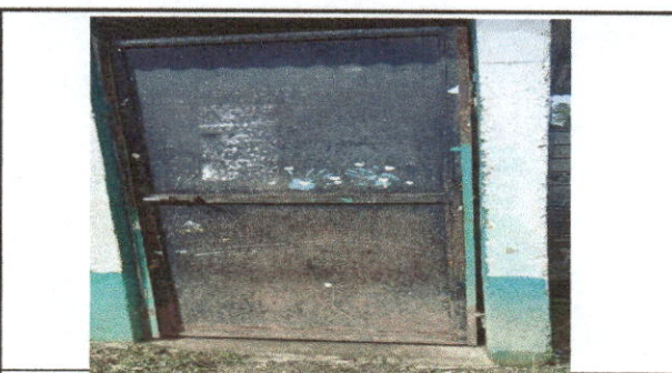
Foto 6: SUSTITUCION DE PUERTA DE METAL
