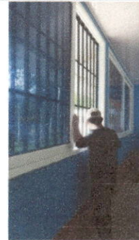
Foto: 2 SUSTITUCION DE VENTANAS POR VENTANAS DE VIDRIO Y PVC
