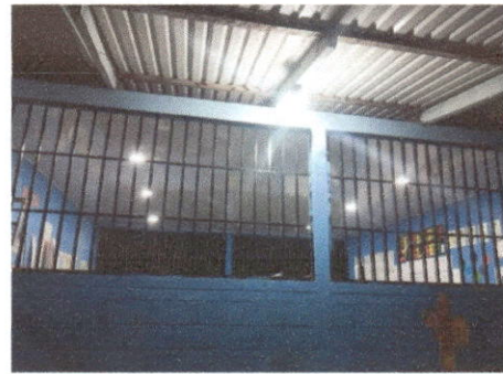
Foto: 4 REPARACION SISTEMA ELECTRICO
