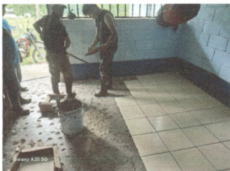
Foto 1: SUSTITUCION DE PISO POR CERAMICO
