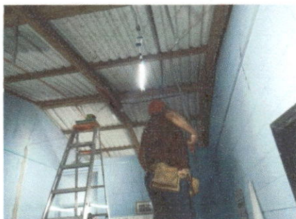
Foto: 3 REPARACION SISTEMA ELECTRICO
