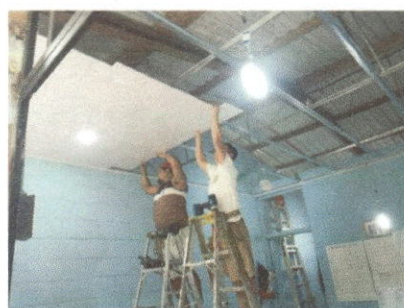
Foto: 4 REPARACION SISTEMA ELECTRICO
