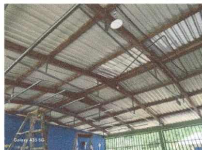
Foto: 6 REPARACION SISTEMA ELECTRICO
