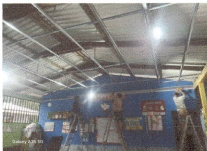
Foto: 5 REPARACION SISTEMA ELECTRICO
