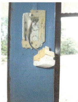
Foto 3: REPARACION SISTEMA ELECTRICO
