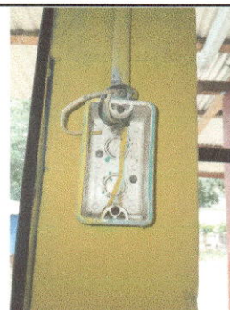
Foto 4: REPARACION SISTEMA ELECTRICO
