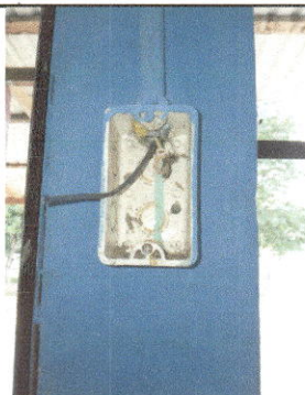
Foto 5: REPARACION SISTEMA ELECTRICO
