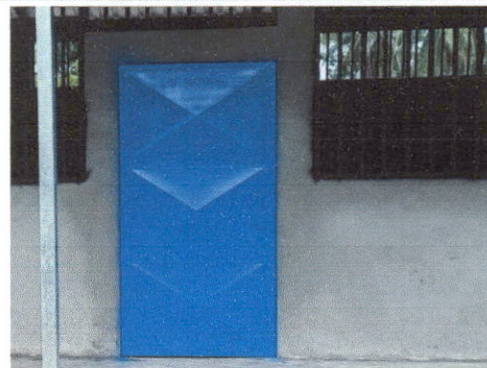
Foto 2: Sustitución de puerta.
