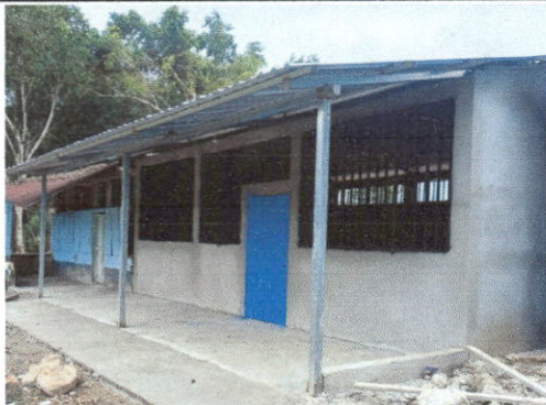
Foto 1: Sustitución de lámina, por lámina troquelada aluzinc calibre 26 y Sustitución de estructura de soporte de madera, por metal
