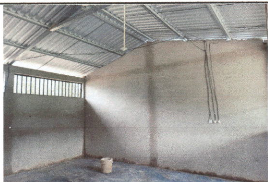
Foto 5: Reparación de sistema eléctrico.
