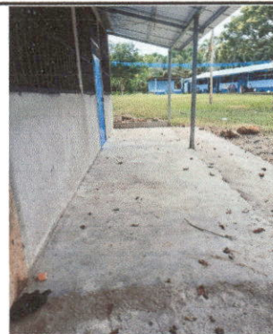
Foto 4: Reparación de piso de torta de concreto
