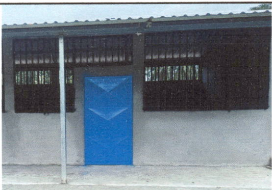
Foto 3: Sustitución de balcones de metal
