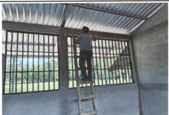
Foto 3: Sustitución de balcones de metal
