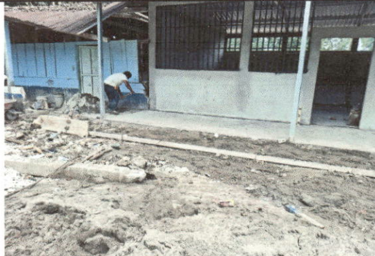
Foto 4: Reparación de piso de torta de concreto
