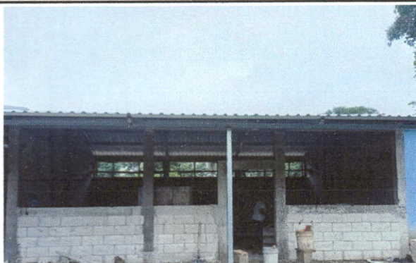
Foto 7: Reparación de muro de contención y repello.
