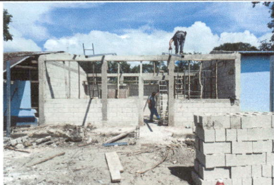
Foto 1: Sustitución de lámina, por lámina troquelada aluzinc calibre 26 y Sustitución de estructura de soporte de madera, por metal
