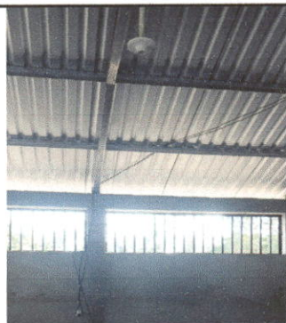
Foto 5: Reparación de sistema eléctrico.
